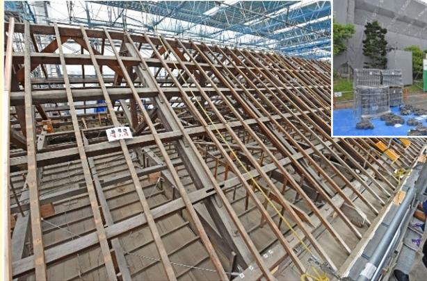
足場の階段を登ると、屋根瓦、杉皮、屋根土が降ろされ垂木だけとなった全長68mの大屋根の木組は圧巻で、普段は見ることのできない光景に参加者は感慨深げでした。屋根瓦は「土葺き」から現在の土を使わない建物に負担の少ない工法に変更され、外壁の塗料も剥がした後、塗装され今年12月には美しくよみがえるとの事です。『明治校舎』は明治33年(1900)旧制中学校建築として、上野丸之内に竣工された木造平屋建洋風の外観が美しい白亜の校舎で、三重県四校のうち唯一現存する校舎です。
